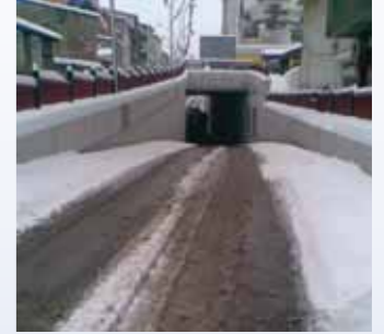
Kasımpaşa Alt Geçidi - Erzurum Araç yolu
